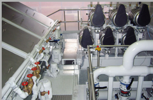
Finomszűrést megvalósító szűrőtárcsás egység egy kombinált berendezésen
